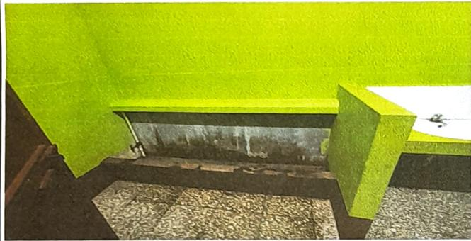
Foto1: sustitución de azulejo y sustitución de llave de mingitorio
