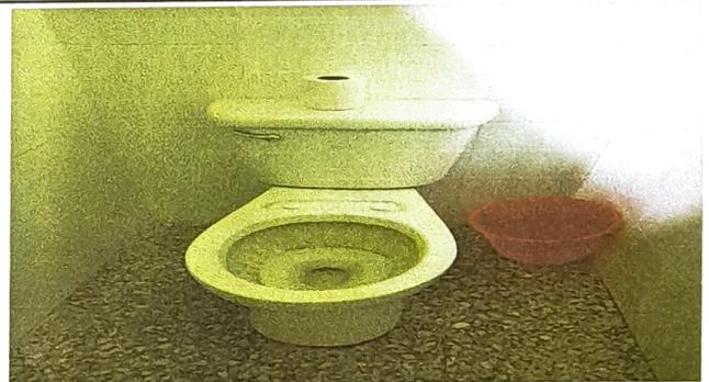
Foto 4: sustitución de tapaderas de sanitarios
